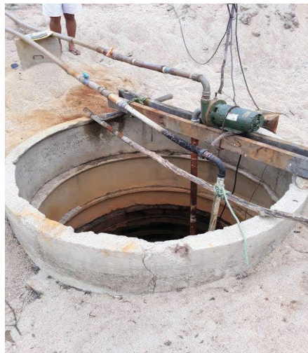
Figura 02: Fonte de captação Fonte: próprio autor
