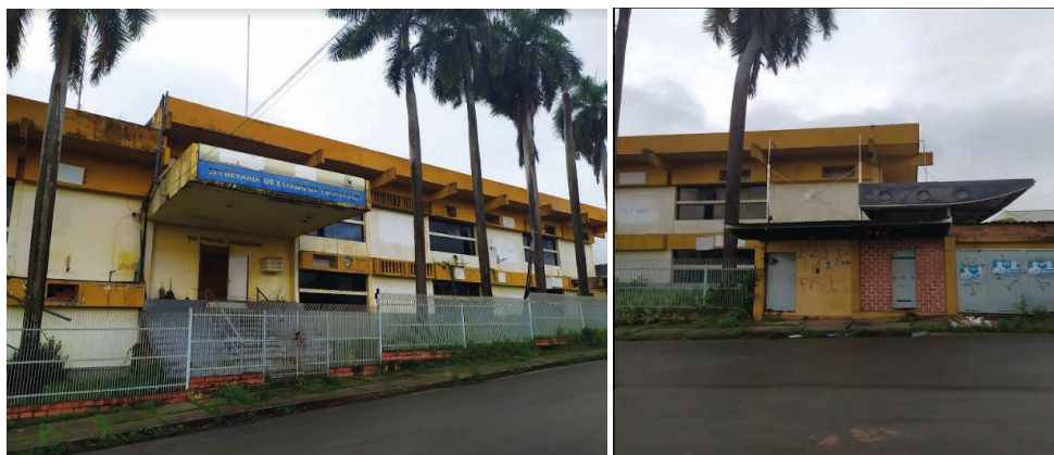
Figura 5 – Fachada principal da Seduc e acesso a garagem
