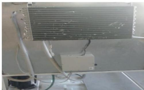
Figura 2. Vista posterior - cámara de frío-condensador
