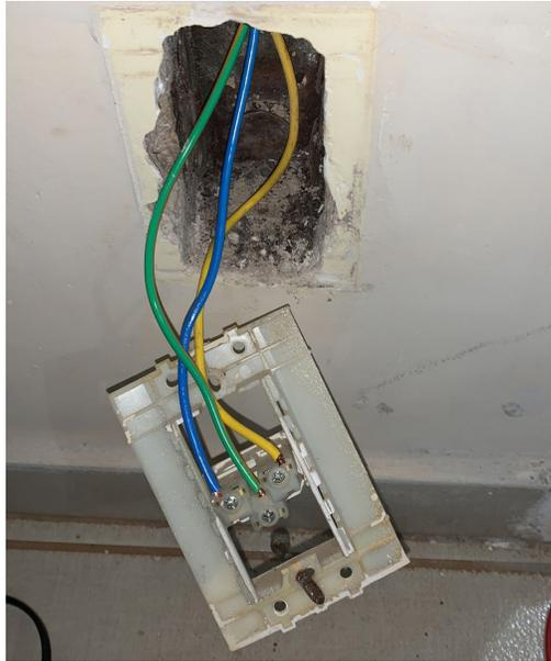
Figura 13- tomada com aterramento (fonte autor)
