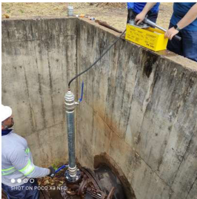
Figura 2. Bomba manual utilizada para inserir pressão positiva
