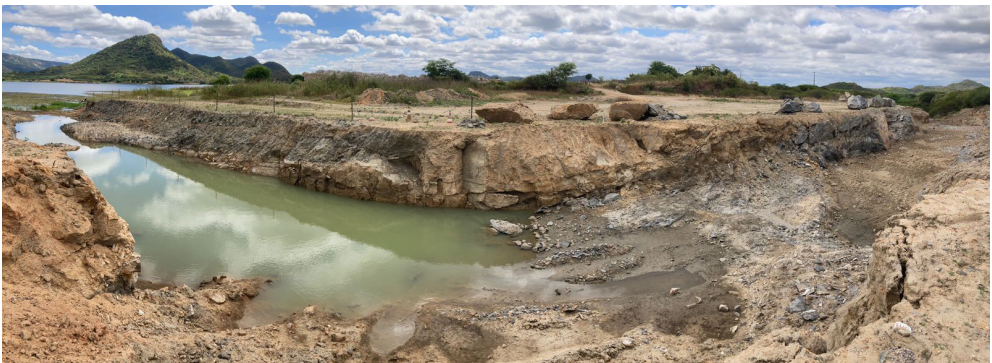
Figura 10 – Obra de abertura do vertedouro, aonde pode ser analisada a geologia local, com a presença de duas litologias (granito e gnaiss) diferentes.
