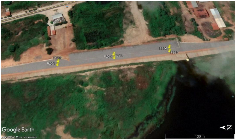
Figura 4 – Os seis piezômetros instalados na barragem auxiliar.
