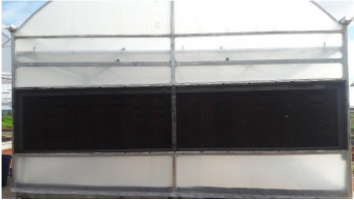
Figura 5b. Vista de trás da casa de vegetação climatizada.
