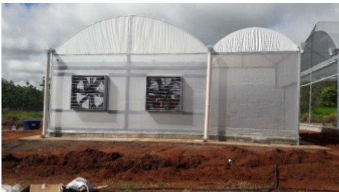
Figura 5a. Vista frontal da casa de vegetação climatizada.
