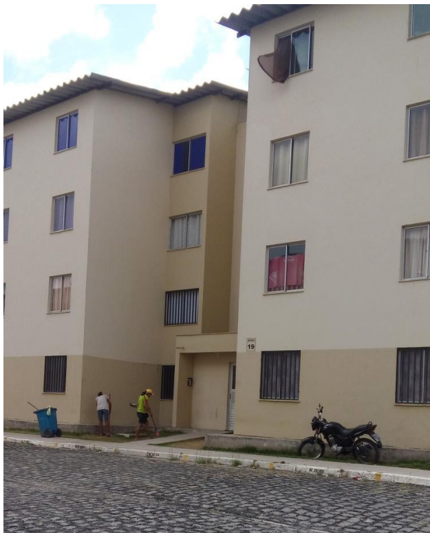
Figura 7 – Trabalho de Limpeza do Condomínio
