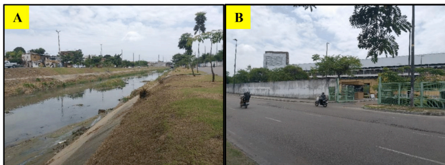
FIGURA 3 – Imagem A: Canal de drenagem a esquerda assoreado e Imagem B - A direita, vista da entrada dois do Studio 5 Mall
