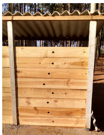
Figura 3. Composteira com o fechamento frontal em tábuas furadas para introdução da sonda
