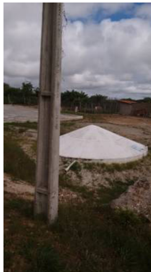
Figura 5. Cisterna construída para o armazenamento de água da comunidade.
