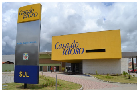
Figura 1 – Fachada da Casa do Idoso Sul
