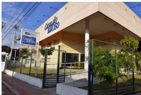
Figura 4 – Fachada Casa do Idoso Norte
