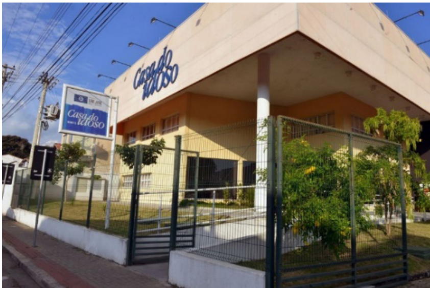
Figura 12 – Fachada Casa do Idoso Norte
