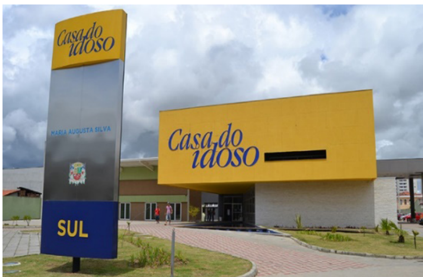
Figura 9 – Fachada da Casa do Idoso Sul
