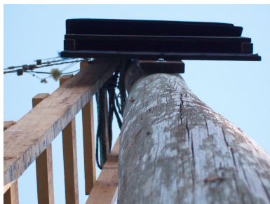
Fig. 3: Vista inferior da bat house
