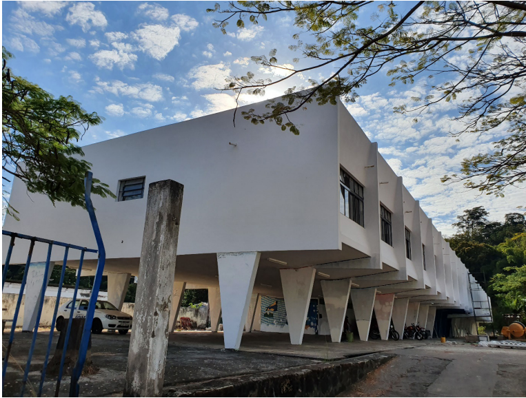
Figura 2 – Colégio Professor Alcide Jubé. Vista geral do volume arquitetônico elevado sobre pilotis deixando o pavimento térreo livre na, quase, totalidade de sua extensão.
