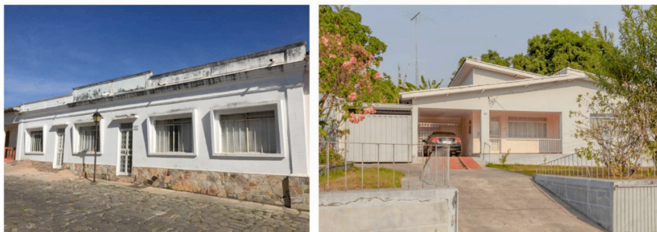
Figura 1 – Exemplos de edificações residenciais pertencentes à primeira categoria (à esquerda) e à segunda categoria (à direita) pertencentes ao Conjunto Arquitetônico e Urbanístico da cidade de Goiás.
