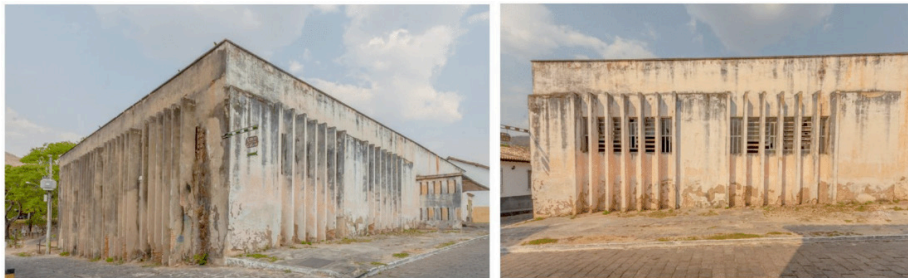
Figura 4 – Edificação do antigo Clube Recreativo Cantagalo: volumetria rígida e repetição ritmada de elementos verticais ocultam as fenestrações reforçando o partido de fechamento para o exterior. Fonte: Foto de Alisson Andrade, 2019.
