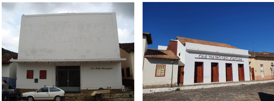
Figura 5 – Cine Teatro São Joaquim, à esquerda, em sua configuração antes das obras de requalificação e, à direita, após as mesmas, transformadas em reconstrução : gabarito mais elevado e substituição da tipologia moderna por outra que se assemelhe mais à feição histórica tradicional predominante na cidade.
