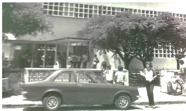
Figura 2- Entrada Principal do Ginásio de Aplicação
