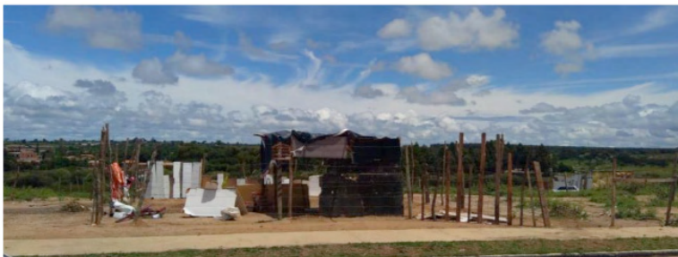
Fotografia 4 - Campinhos: Ocupação em área remanescente do Residencial Lagoa Azul
