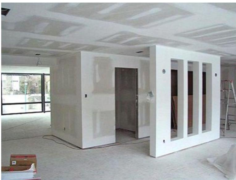
Figura 2 - Paredes de gesso acartonado
