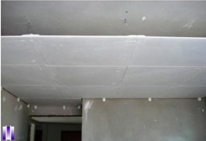
Figura 4 - Rebaixamento / Forro de gesso
