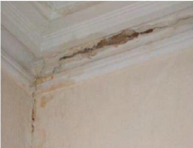
Figura 9 – Gesso danificado pela umidade
