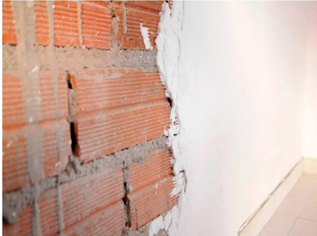
Figura 5 - Revestimento de gesso
