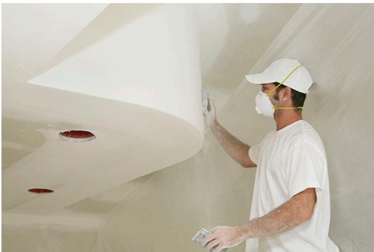
Figura 7 - Aplicação de revestimento com gesso
