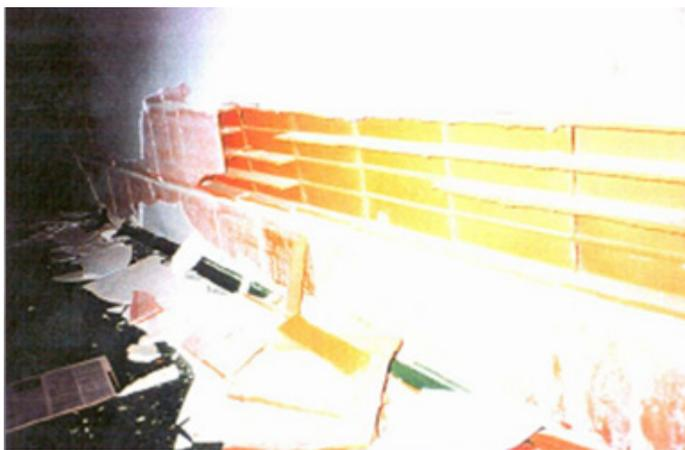
Figura 8 – Revestimento interno não suporta a base
