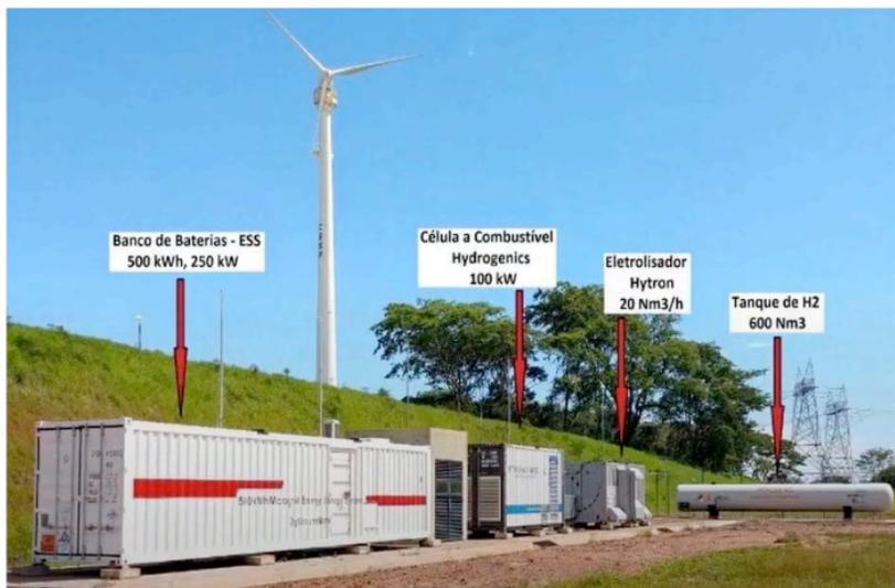
Figura 1 – Sistema de Armazenamento de Energia Elétrica na forma de hidrogênio instalado na UHE de Porto Primavera (6)
