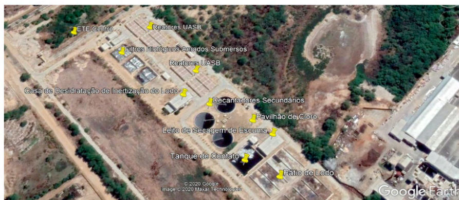
Figura 1. Visualização de satélite da Estação de Tratamento de Esgoto Centro, evidenciando suas unidades operacionais.
