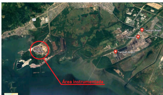
Figura 1. Localização via satélite da obra da TKCSA - pós construção (Google Maps).
