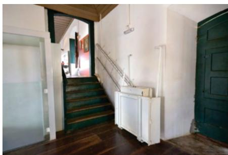
Fig. 07 Plataforma elevatória no segundo pavimento.
