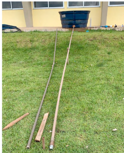
Figura 02 – Instalação da Caixa d'água de 1000 Litros
