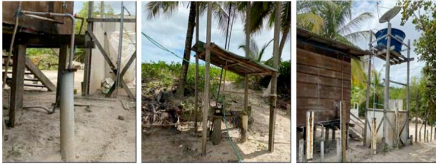
Figura 2 – Poços artesianos, bombas e armazenamento em caixas d'água de mil litros, na comunidade pesqueira Olho de Porco, Paço do Lumiar, MA, Brasil.
