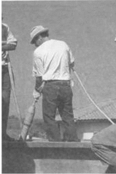
Figura 9: Taipa mecanizada
