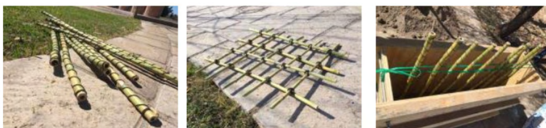
Figura 2. Corrugado en carrizo, diferencias de armado y colocación de refuerzo.
