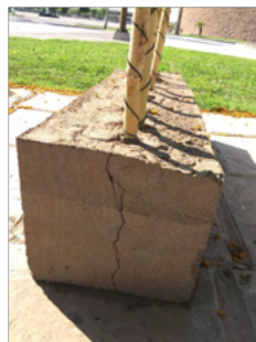
Figura 4. Agrietamiento en muros con suelo de Lerdo Durango.
