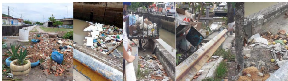
Figura 10 – Descarte irregular de resíduos ao longo do canal.
