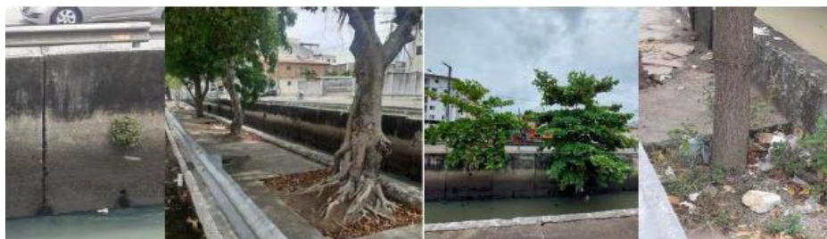
Figura 12 – Presença de vegetação. Fonte: Os autores (2022)
