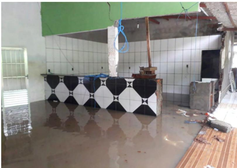
Figura 5. Casa inundada no Banco da Vitória apresentando fissura na parede superior.
