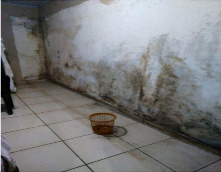
Figura 6. Infiltração e bolor em parede danificando a pintura após o desastre no Banco da Vitória.
