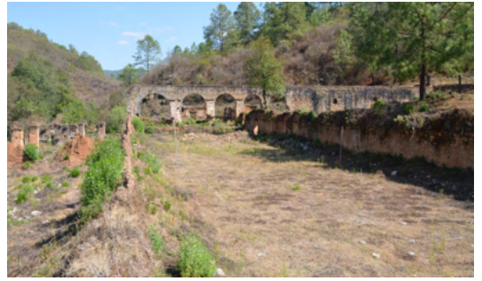
Foto 4.- Patio de molinda.
