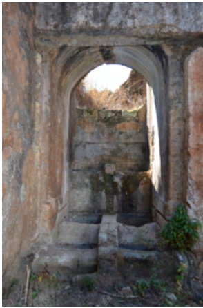
Foto 5.- frontal pilas de lavado.
