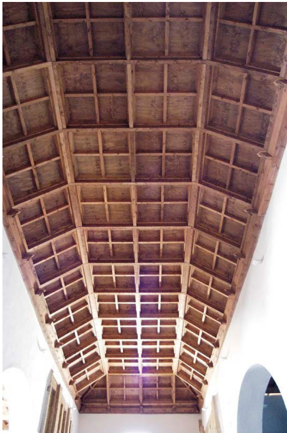
Fig. 12 Vista general de la armadura de la nave principal finalmente ejecutada.
