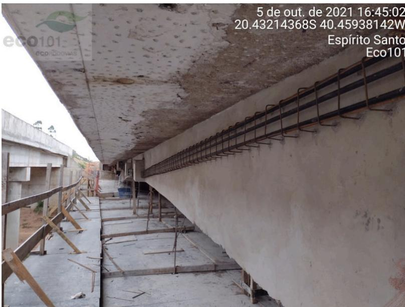
Figura 10 – Foto dos Cabos com Armadura da Proteção contra Vandalismo.
