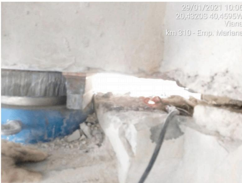
Figura 13 – Corte da Armadura Passante com Arco Elétrico.
