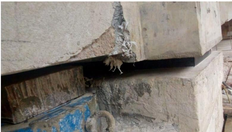
Figura 14 – Aparelho de Neoprene Posicionado.
