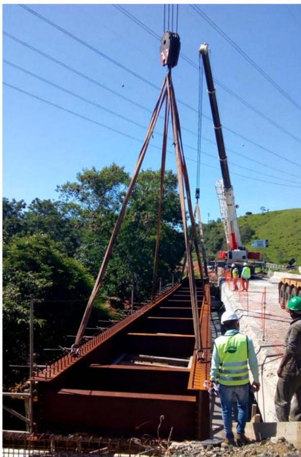
Figura 7 – Lançamento da Estrutura de Aço com Guindastes.
