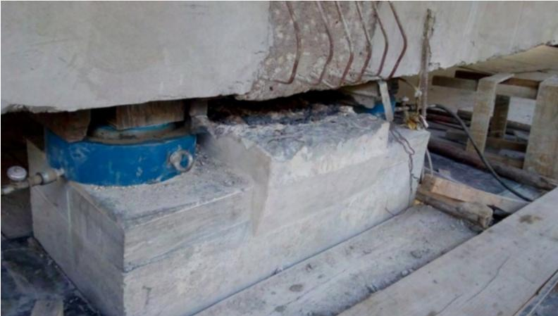
Figura 12 – Suspensão da Longarina para Transferência de Cargas.
