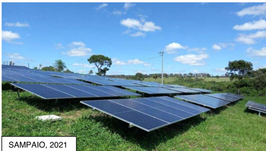
Figura 3. Unidade solar implantada para cobrir a conta de energia de irrigação localizada de 82 ha de avocado 'hass', Arealva (SP).
