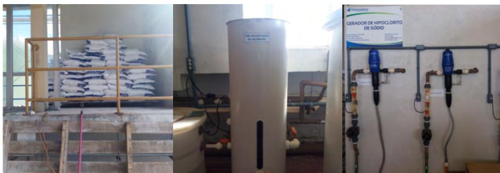
Figura 7: Sistema de purificação do hipoclorito de sódio.
