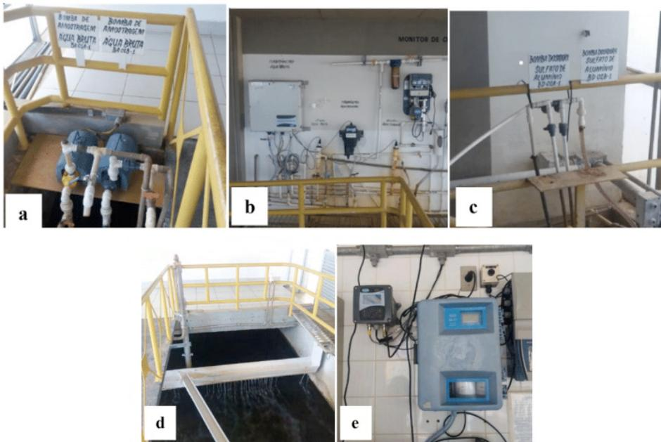
Figura 4: **(a)** sistema de controle de recepção de água bruta; **(b)** medidores de pH, cor, turbidez da água bruta e após o processo de coagulação e decantação em tempo real; **(c)** dosador de cal virgem e PACI; **(d)** distribuição da cal virgem e PACI na água bruta e **(e)** painel de controle, dentro do laboratório, que transmite informação de pH, cor, turbidez em tempo real para o operador; na ETA Bom Jardim - Uberlândia.
