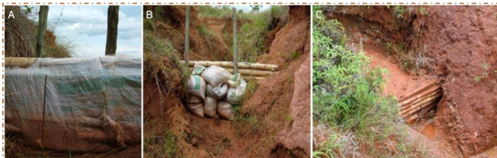
A: Representação de uma barreira revestida com sacos de rafia; B: representação de uma das barreiras com paliçadas de bambú e sacos de rafia servindo de escora; C: material fino retido nas barreiras de bambú.
