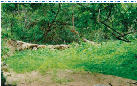
Efeito da retenção de sedimentos com ressurgimento da vegetação, após as chuvas.
