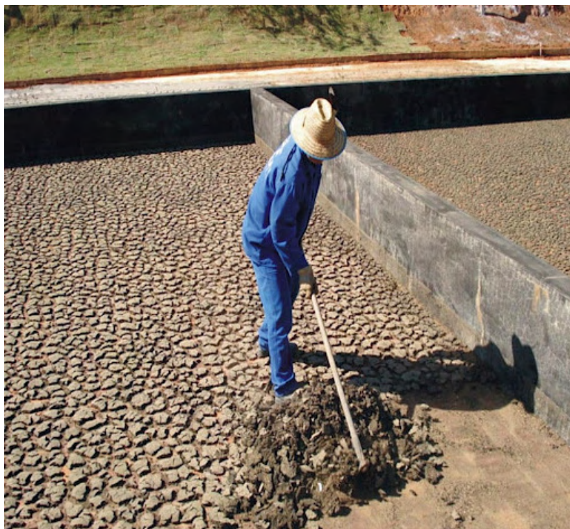
Figura 17: Leito de secagem de lodo.
