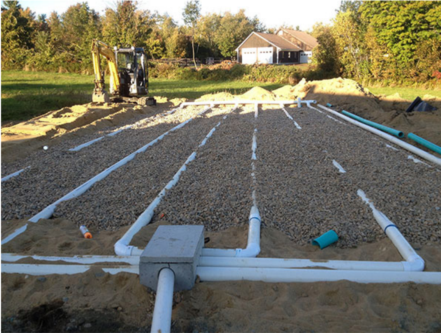
Figura 15: Vala de infiltração.
