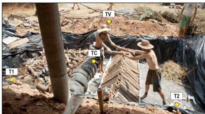
Figura 2 - Sistema interno do TEvap.
