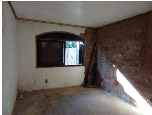
Figura 9 - Ensaio destrutivo parede interna sul dormitório 02.
