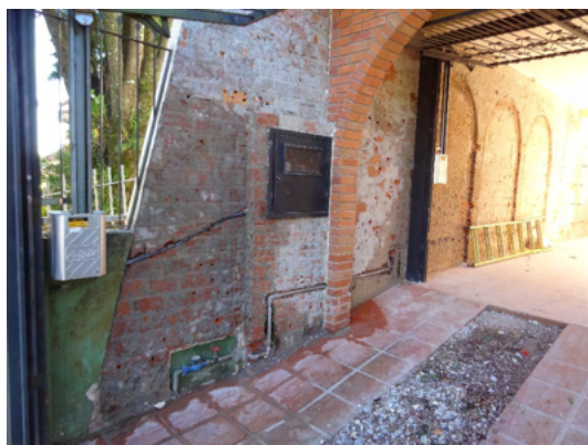
Figura 13 - Ensaio destrutivo junto a parede da entrada de água.
