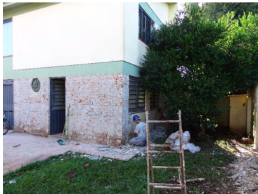
Figura 6 – Ensaio destrutivo parede externa lavanderia.
