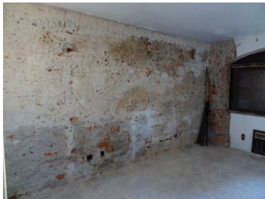
Figura 11 - Ensaio destrutivo parede interna sul dormitório 01.
