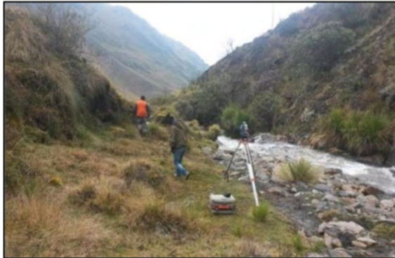
Fig 5. Emplazamiento de la obra de toma, en río Macara.
