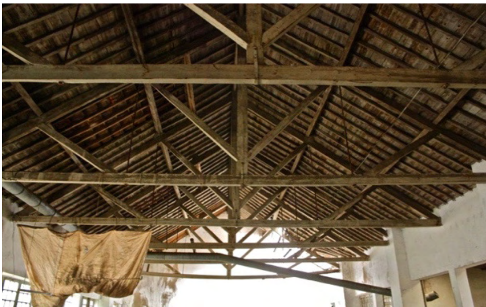
Figura 6: Estrutura da cobertura em madeira.
