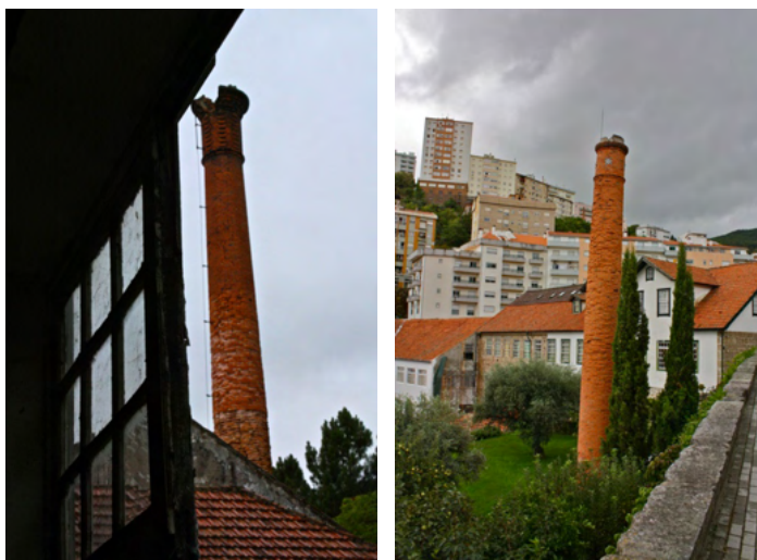
Figura 3: Chaminés industriais em tijolo.
