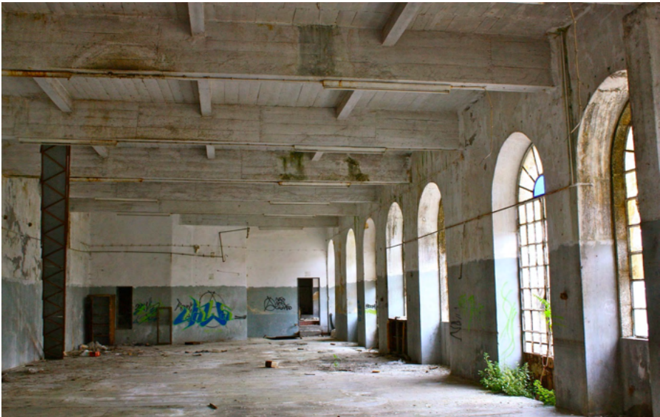
Figura 8: Sala ampla do piso térreo.
