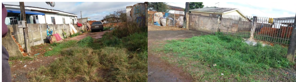
Figura 2 - Precárias infraestruturas habitacionais no bairro Morro Alto.
