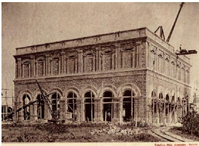
Figura 1 – Cópia fotográfica do Reservatório de Mocó, em construção. Final do século XIX.
