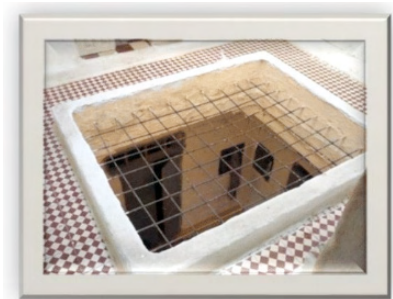
Terraza y claraboya en casa-patio, 2019
