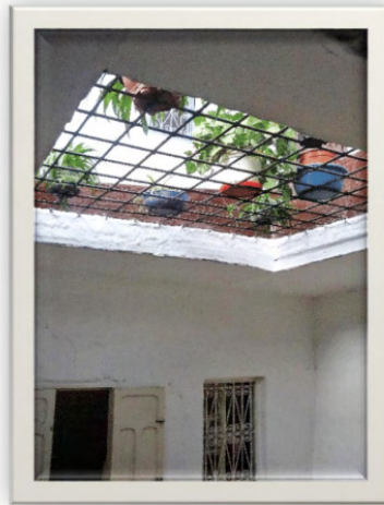
Claraboya en casa-patio del mellah , 2019
