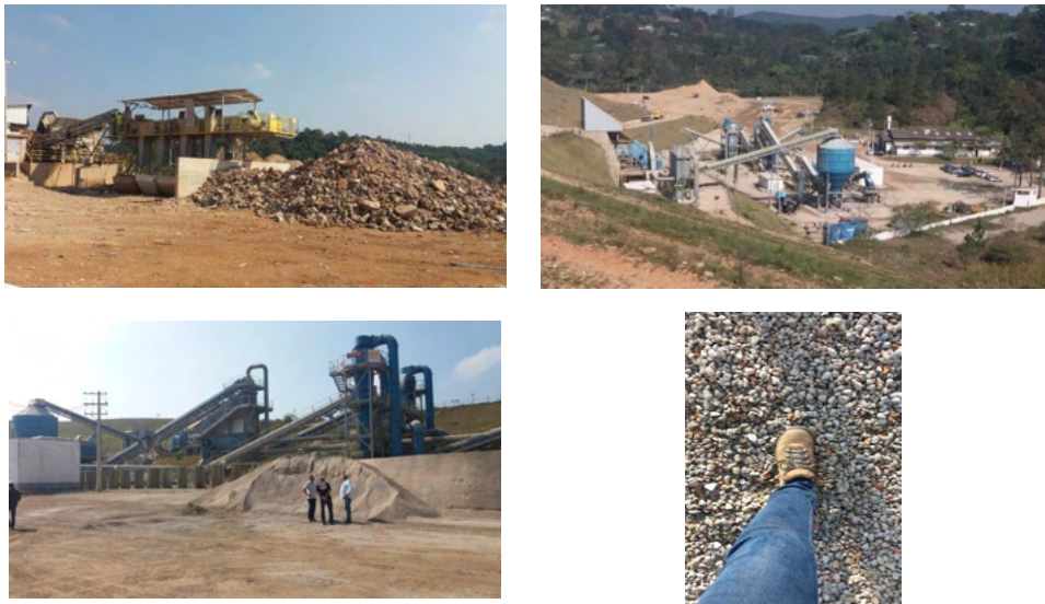
Figura 1 - Visão geral - URV Construção Civil Grajaú.
