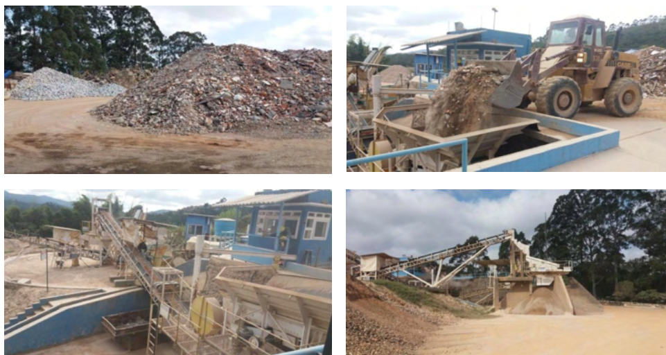
Figura 2 - Visão geral - Usina de Reciclagem de Resíduos da Construção Civil Proguaru.
