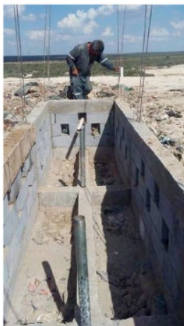
Imagen 5. Preparación para la base del quemador.
