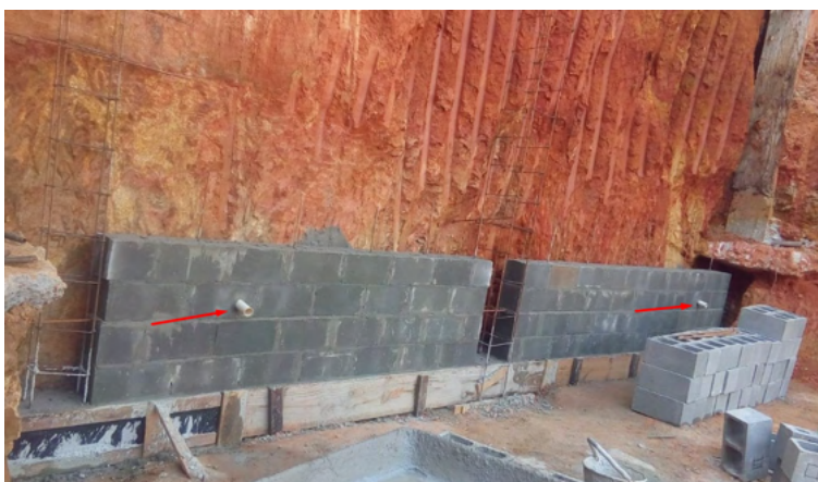
Figura 7 - Instalação de barbacãs (Acervo Fotográfico do Autor)..
