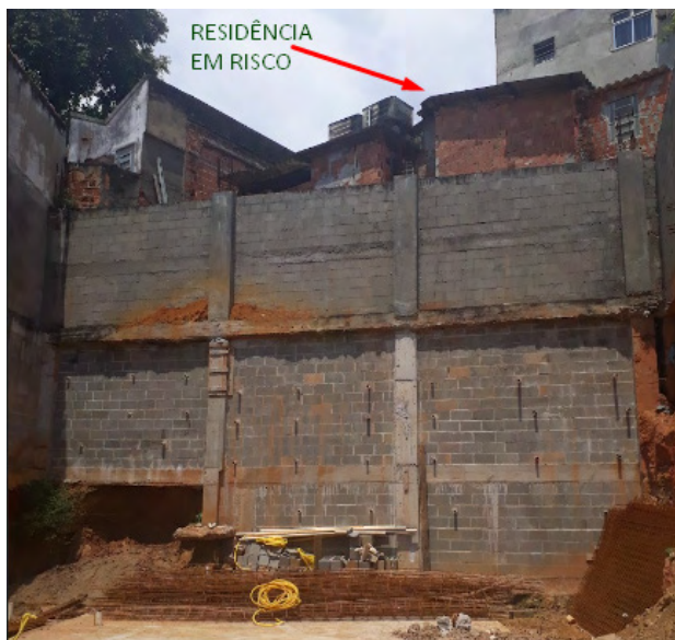
Figura 8 - Muro novamente construído (Acervo Fotográfico do Autor)..
