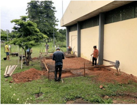
Figura 04 – Nivelamento do terreno e gabarito da obra.
