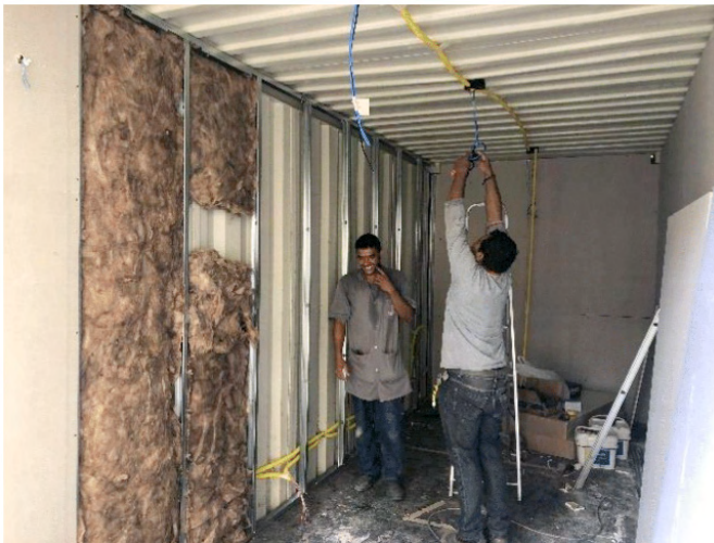
Figura 05 – Tratamento termo acústico do interior do container.
