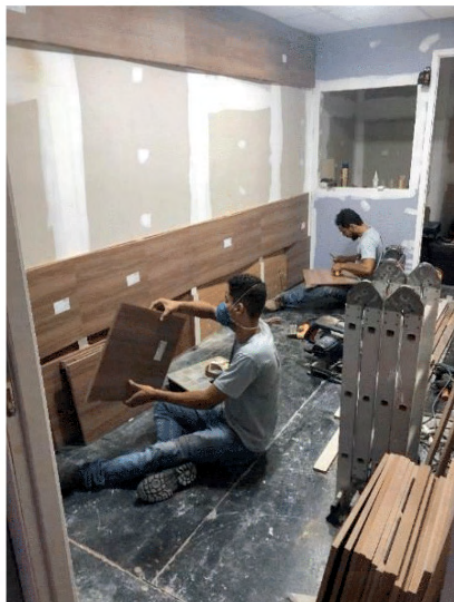
Figura 06 – Instalação do drywall e defletores de som.
