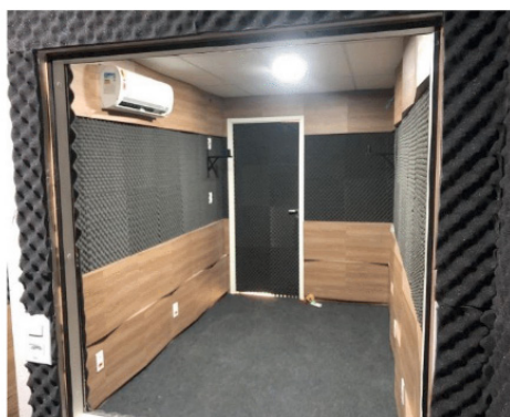
Figura 07 – Instalação das espumas acústicas.
