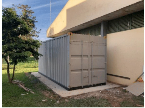
Figura 04 – Concretagem da base e locação do Container.
