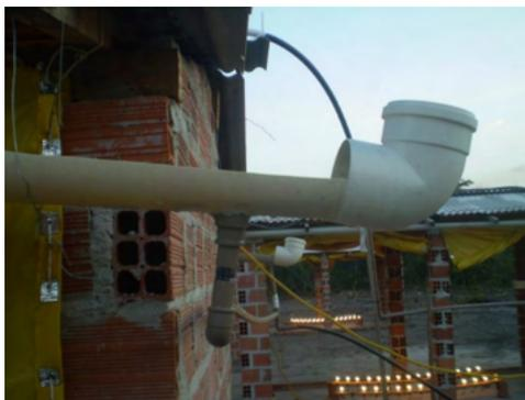
Figura 03. Visão lateral do sistema de reaproveitamento da água.
