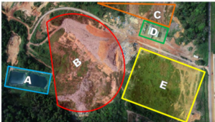
Figura 5. Distribuição das áreas do Aterro do Perema, no município de Santarém, Pará. (A) Área da Lagoa de chorume, (B) Área destinada para Resíduos Domiciliares, (C) Área destinada para Resíduos de Construção, (D) Galpões de Triagem e (E) Área destinada para Resíduos de Saúde.
