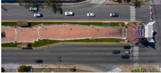
Vista aérea Avenida 27 de febrer.
