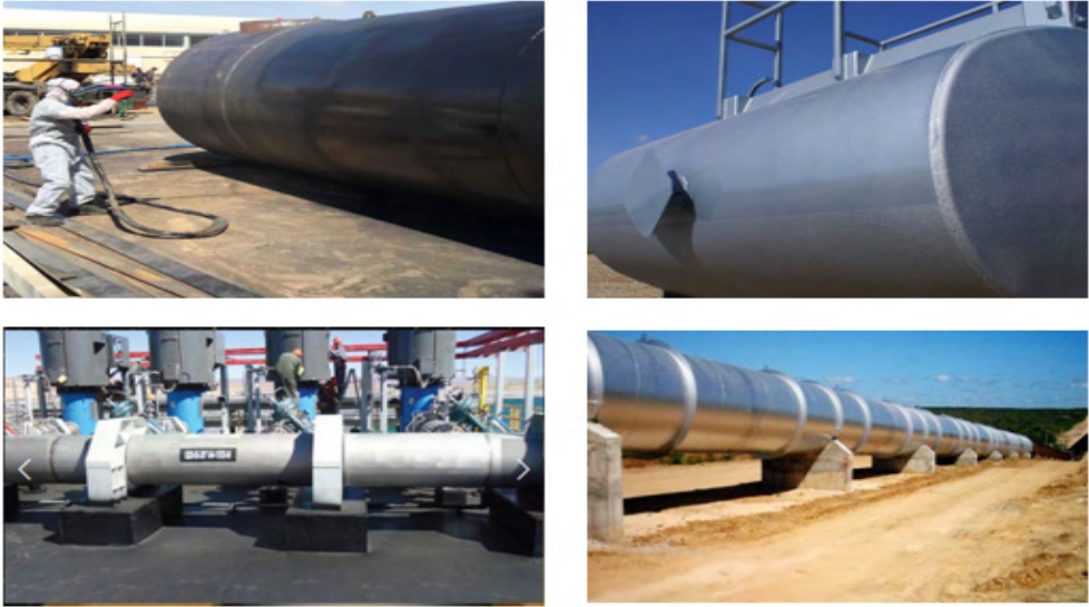
Figura 13 - Aplicação da tecnologia Line-x em dutos.
