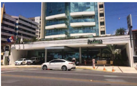
Figura 11 Hotel Radisson (atual Best Western Premier Maceio) - permeabilidade visual.
